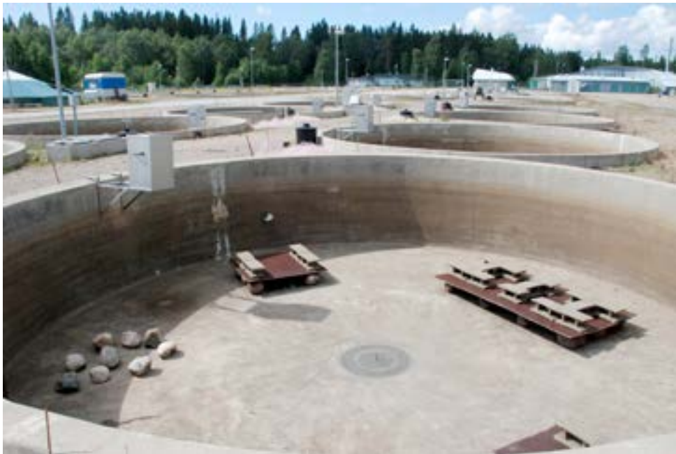
Suuri ulkoallas virikerakenteineen. Allas on tyhjä, jotta tiilet, kivet ja kalojen näkösuojat näkyvät.
